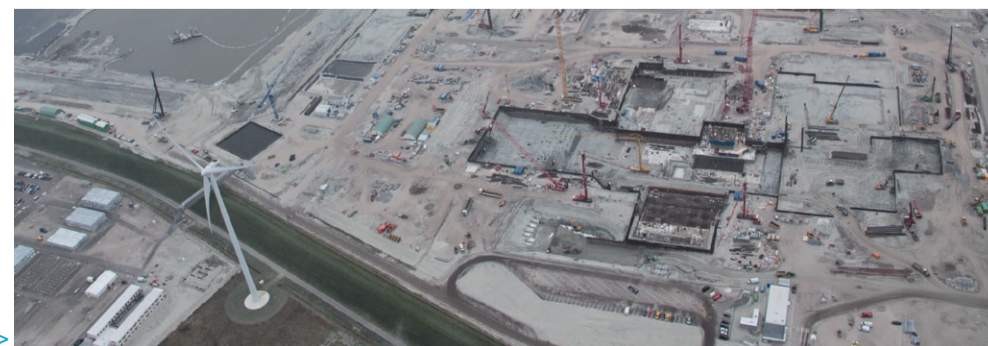
De grote bouwput van RWE met linksboven de heistelling voor de funderingen van de kades aan de verlengde Wilhelminahaven
