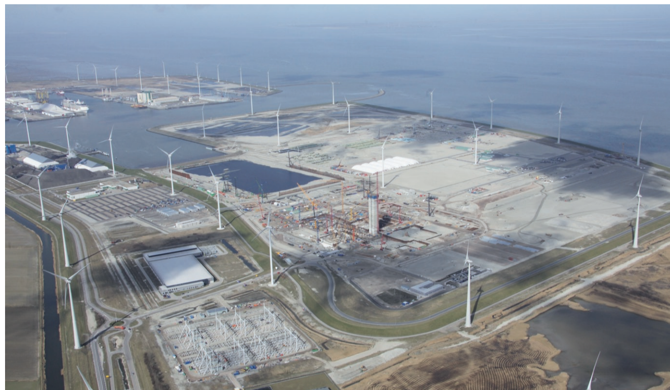
Op bovenstaande foto ziet u ondermeer de bouw van het schakelstation van TenneT, 'de blauwe toren' van RWE en de kadebouw rond de te verlengen Wilhelminahaven.
